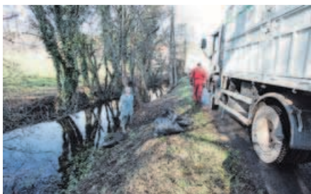
Una de las campañas de limpieza en el Sarela. X. A. SOLER
